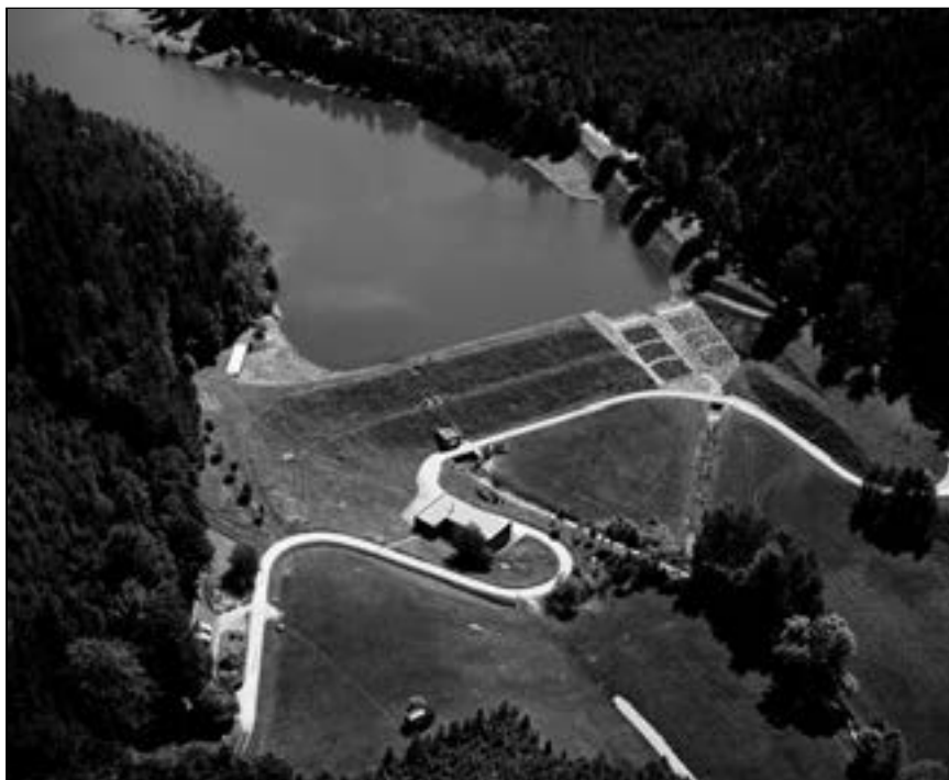
Abbildung 2: Talsperre Krebsbach vor dem Rückbau
