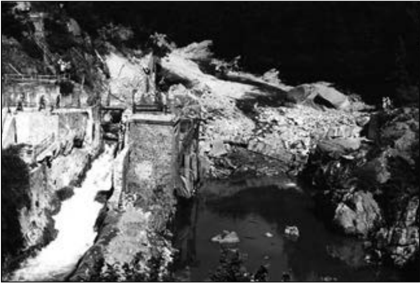
Abbildung 1: Sprengung der Talsperre St. Etienne auf einem Nebenfluss der Loire, rückgebaut 1998
