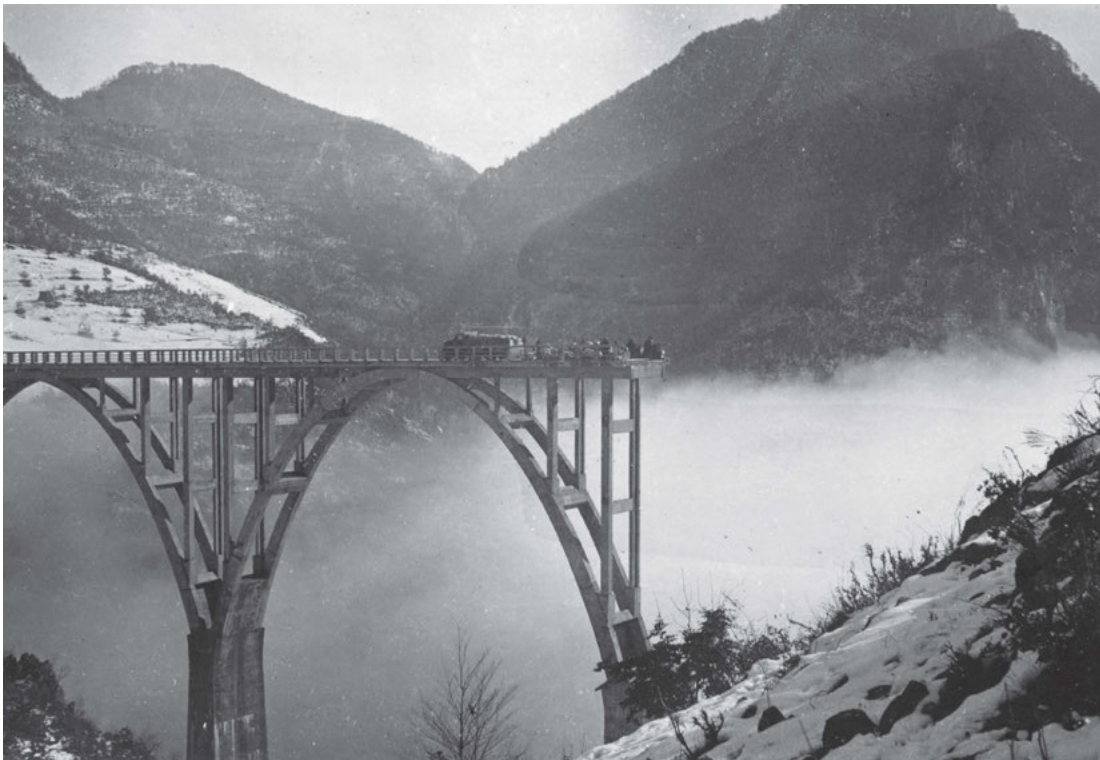
Gesprengte Brücke über dem Fluss Tara, Montenegro, 1943. Fotograf unbekannt. Zagreb, Kroatisches Historisches Museum | HPM-MRNH-F-1043.
